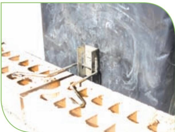
La colocación y fijación del anclaje se realiza antes de la ejecución de la fábrica.
