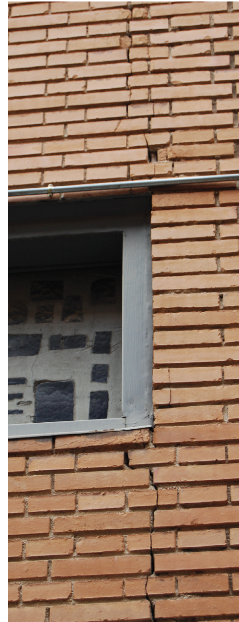
Grietas verticales por discontinuidad geométrica
