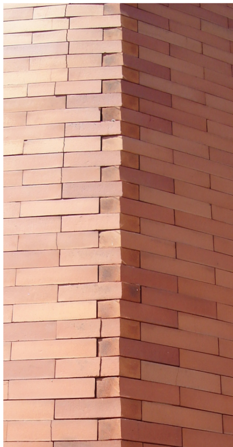
Las paredes que miran al N y O dilatarán más que las otras pudiendo ocasionar fisuras verticales
